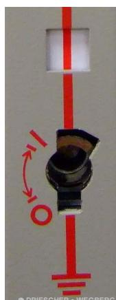
Bild 2: Erdungsschalter in "EIN"-Position
