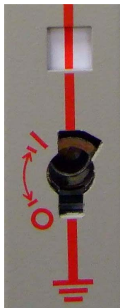
Bild 2: Erdungsschalter in „EIN“-Position Fig. 2: Switch earthing in „ON“-position
