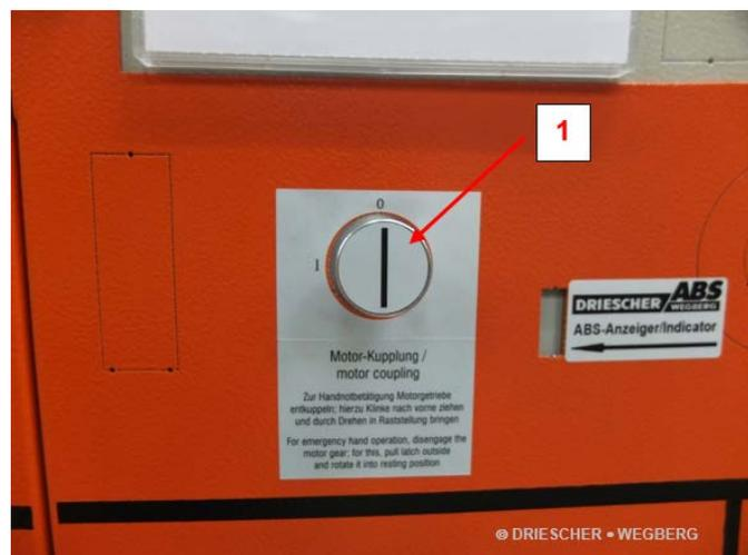
Motorgetriebe entkuppelt / motor gear uncouple
