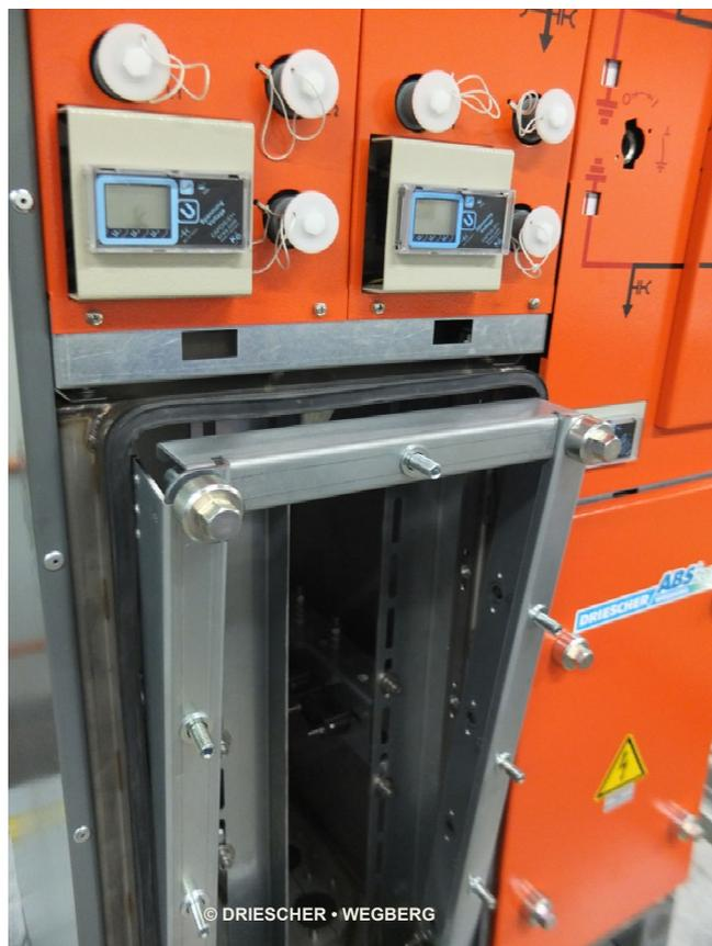
**Entfernen der Kabelhalteisen**
