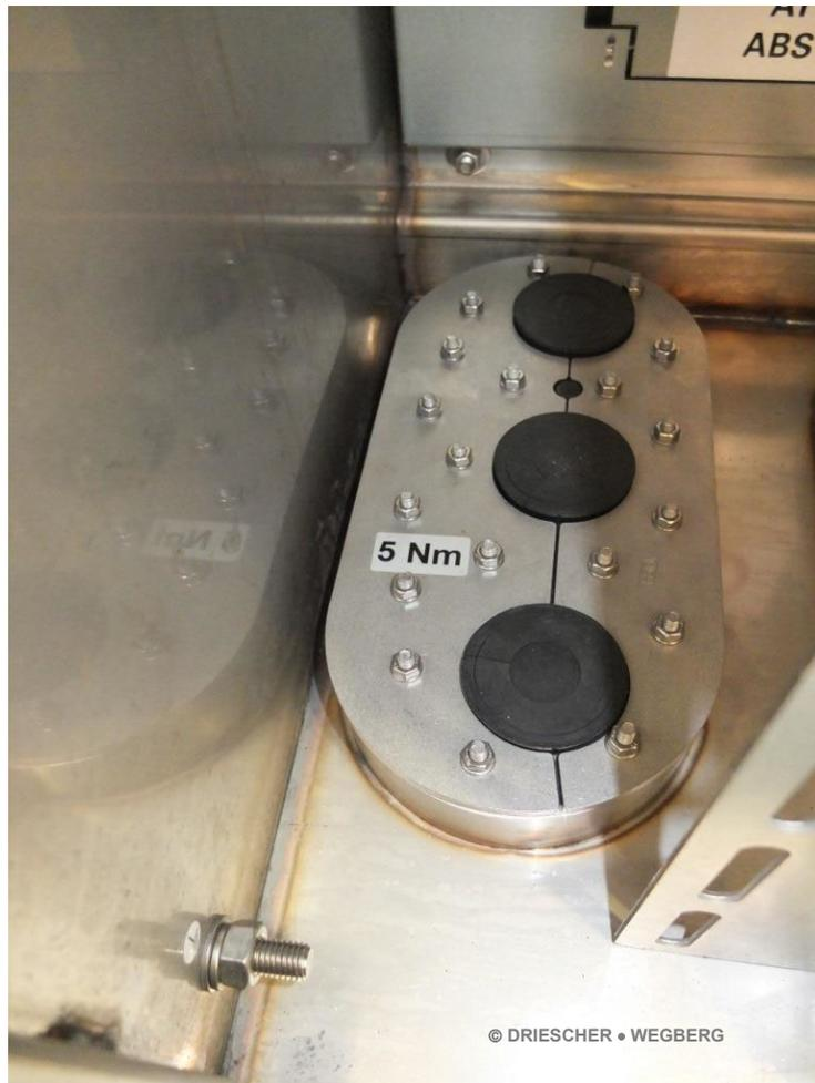
Die Einführung des Erdungskabels erfolgt durch die 11mm – Bohrung innerhalb der Gummipressdichtung
