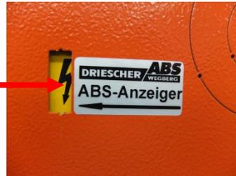
Die manuelle EIN- und AUS-Schaltung kann bei vorgespanntem Antrieb wie üblich vorgenommen werden. Lasttrennschalter und Erdungsschalter sind in der Standardausführung gegeneinander verriegelt. Die Verriegelung lässt allerdings die EIN-Schaltung des Erdungsschalters zur Störlichtbogenbegrenzung, über die **ABS**-Sensoren, unabhängig vom Schaltzustand der Gesamtanlage zu.
