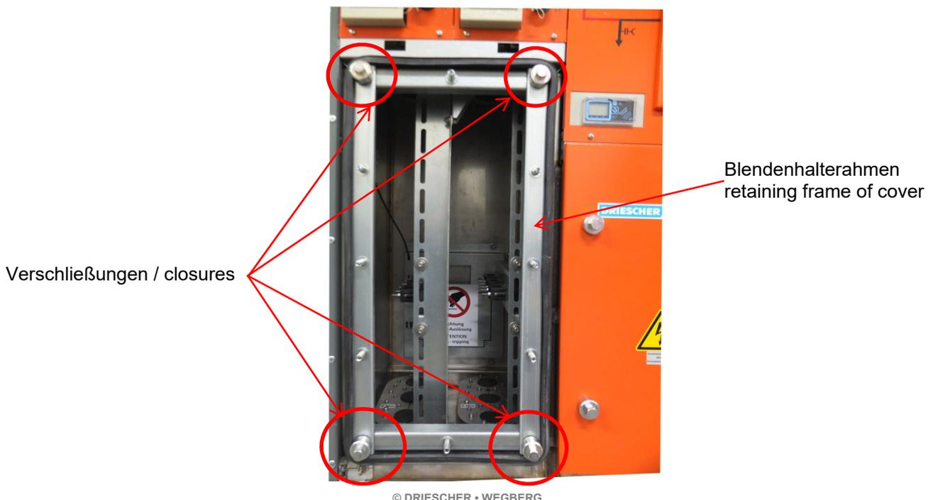
Die Befestigungsschrauben SW 16 (1) befinden sich links und rechts von der Seitenwand
