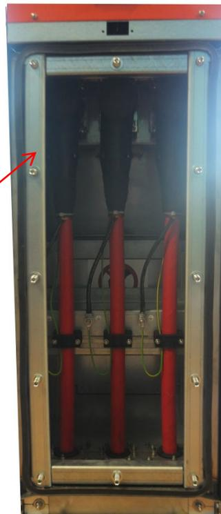
Der Blendenhalterahmen besteht aus 4 Schienen (der Rahmen für das Trafefeld besitzt nur zwei seitliche Schienen). Damit der komplette Rahmen entnommen werden kann, werden an den vier Eckgewindebolzen die Verschlüsse leicht angeschraubt.
