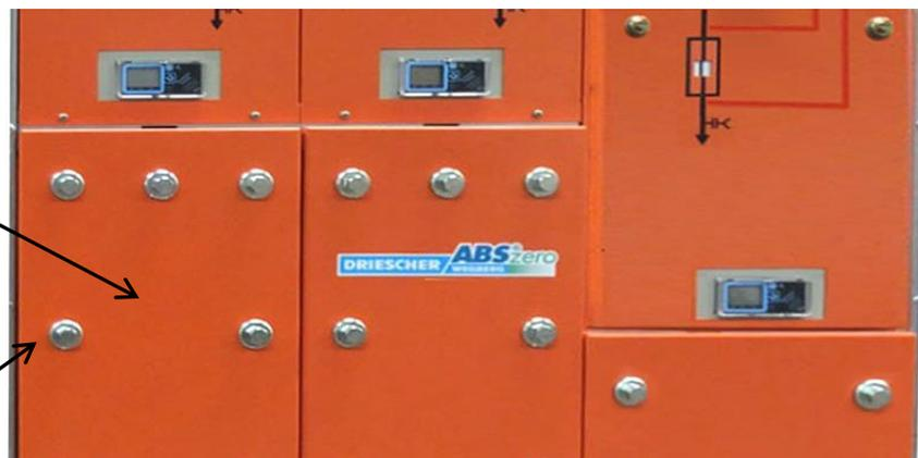
Entfernen der Verschlüßungen, Kabelraumblende nach vorne horizontal abnehmen.
