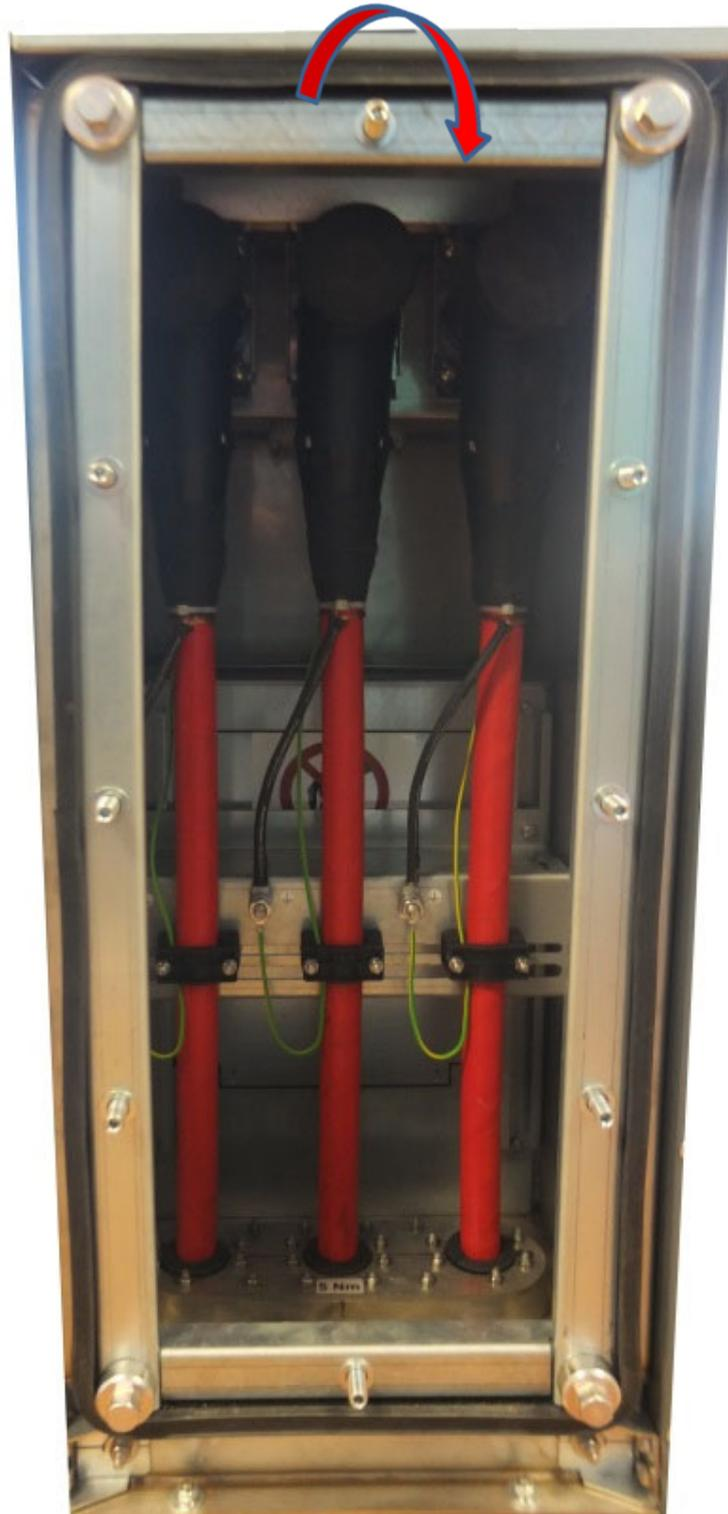
Entfernen der Zwiebelnschnitteinsätze aus den Gummi-Press-Dichtungen (Detaillierte Anleitung des Herstellers UGA beachten siehe Anhang A)
