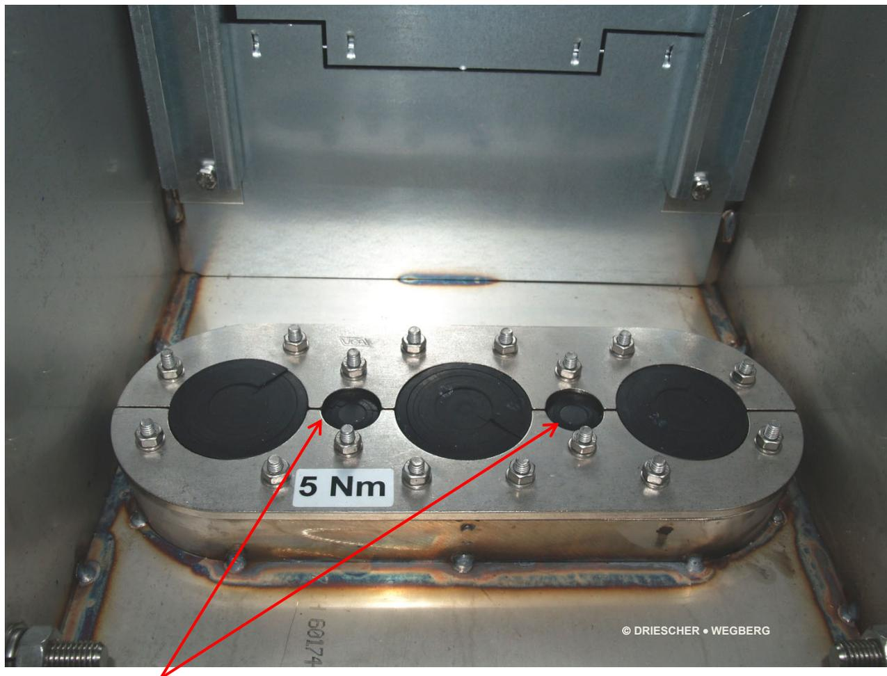
Die Einführung des Erdungskabels erfolgt durch die 4-20mm – Bohrungen innerhalb der Gummipressdichtung
