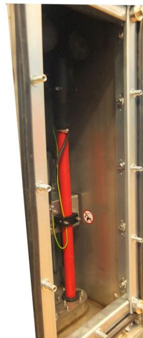
Nach dem Lösen der Befestigungsschrauben den Rahmen nach vorne neigen und herausnehmen.
