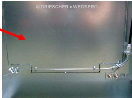
Um eine unsachgemäße Auslösung des Anti-Berst-Systems zu verhindern, ist die Sensorklappe mit dem Verbotsschild – “Berühren verboten” gemäß DIN 4844-2 DGUV Vorschrift 9 versehen.
