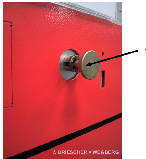
Getriebe entriegelt gear unlocked
