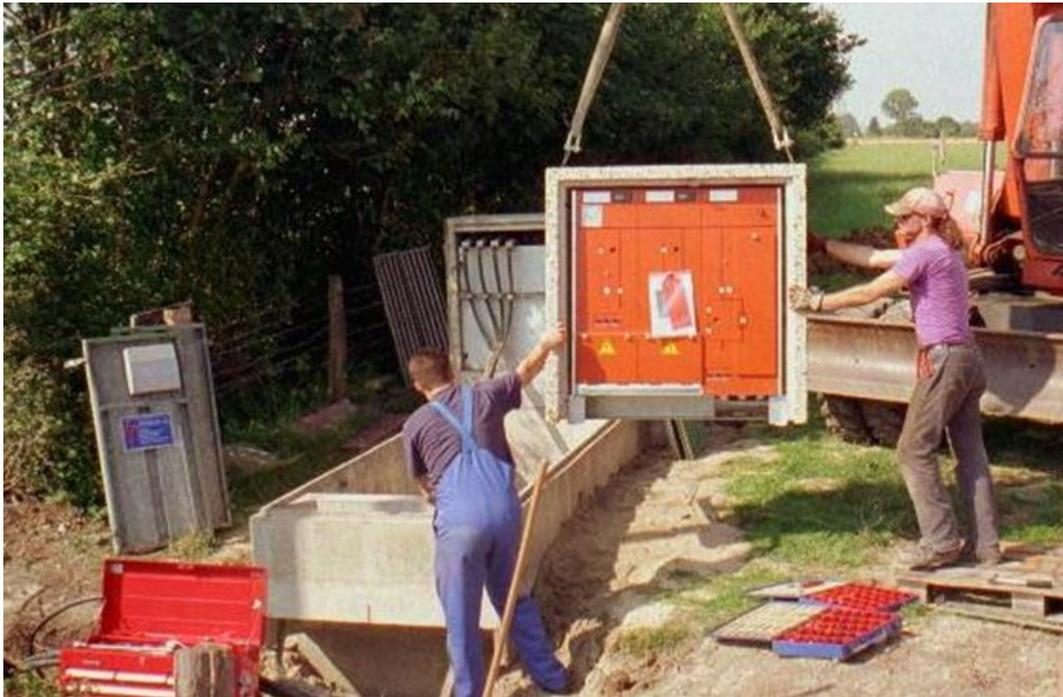
**Komplettes Bauteil mit bereits eingebauter SF<sub>6</sub>-Anlage vom Typ MINEX®**
