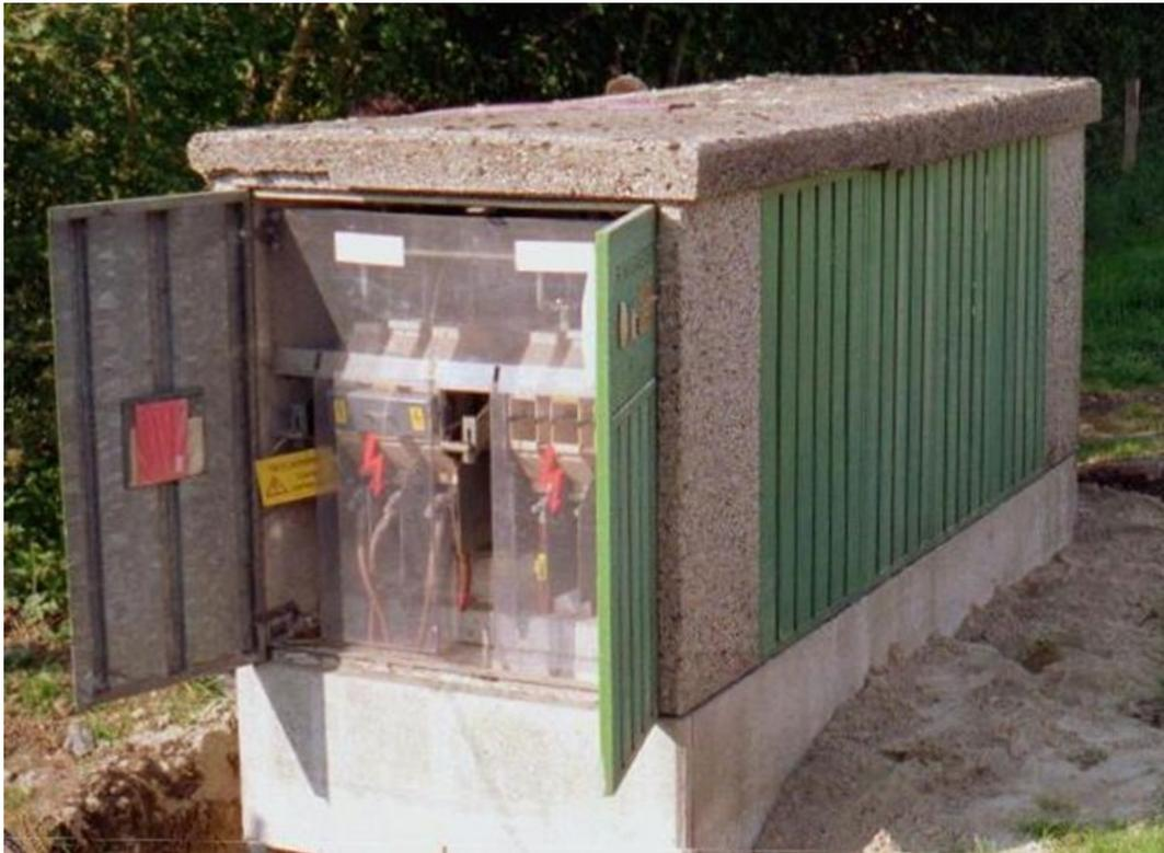
**Wickmann-Station mit Luft-Feststoffisoliertem Lasttrennschalter**
