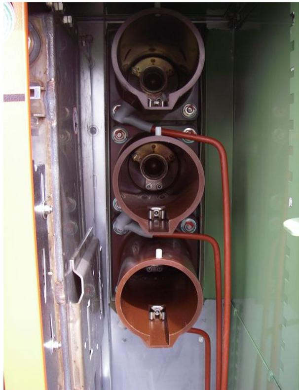
**Ansicht Anbindung Transformatorverbindungsleitung an den gießharzisierten Sicherungsträgern**
