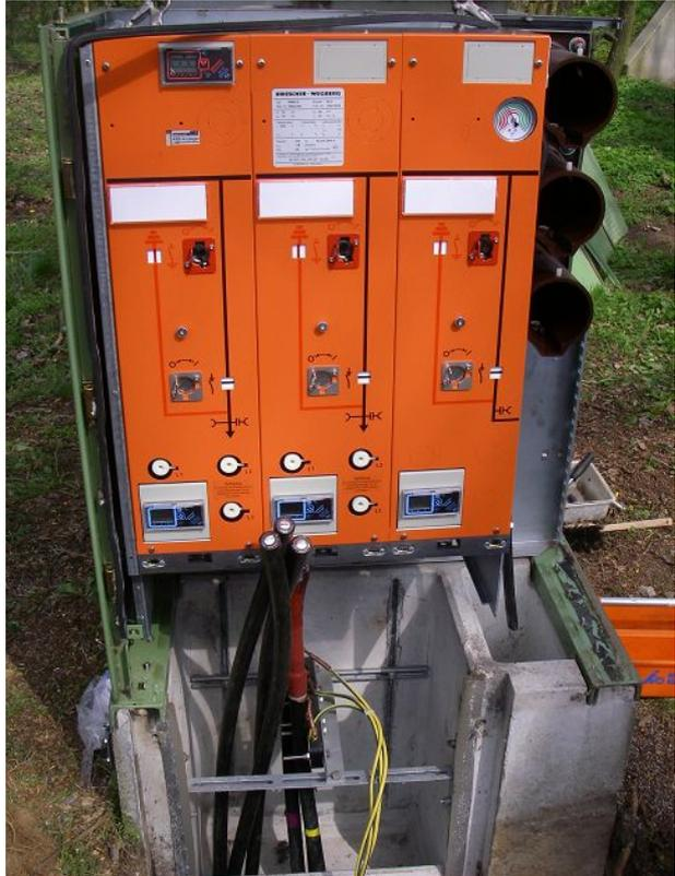
Einbringen und Montage der neuen Schaltanlage
