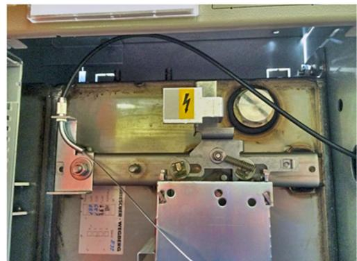
Für den Fall, dass die Aufstellung des Messfeldes links vom Schaltfeld erfolgt, führen Sie den Bowdenzug wie dargestellt von links in das gerade Endstück im Schaltfeld ein.
