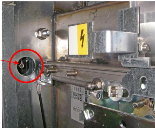
Kopplungsgestänge soweit einschrauben, bis die Kugelpfanne und der Kugelbolzen fluchten, ohne das ABS-Gestänge zu verschieben.
