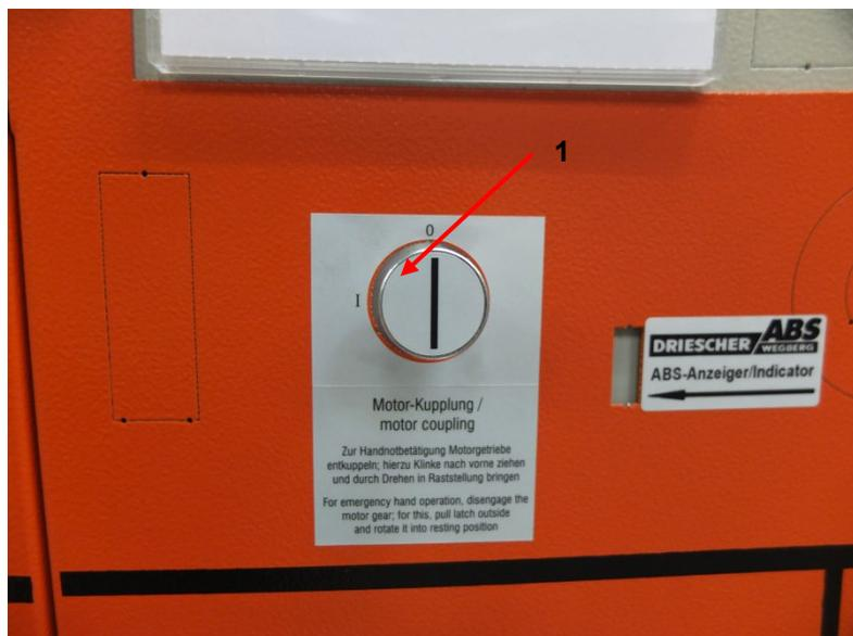
0: Motorgetriebe entkuppelt / motor gear decoupled
