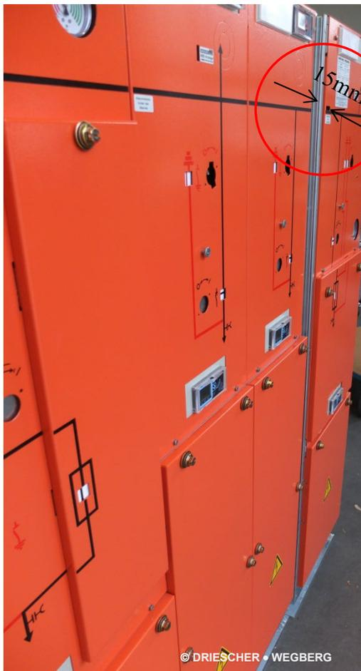
Beim Aufstellen darauf achten, dass die Anlagenteile gerade und auf einer ebenen Fläche aufgestellt werden. Die Anlagenteile müssen mit ihren Seitenwänden bündig zueinanderstehen.
