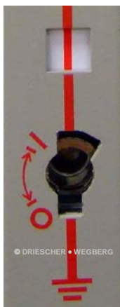
Bild 1: Erdungsschalter "EIN" Fig. 1: Switch earthing „ON“
