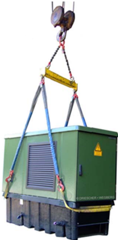
Kranen ohne eingebautem Transformator
