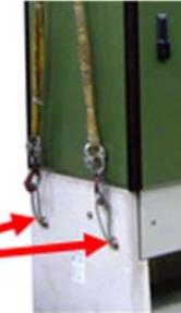
Um ein Verkratzen der Station zu verhindern, werden die Kranungsösen mit Gummi oder Schaumstoff hinterlegt. Alternativ kann auch ein Holzbalken hinter die Kranungsösen gelegt werden.
