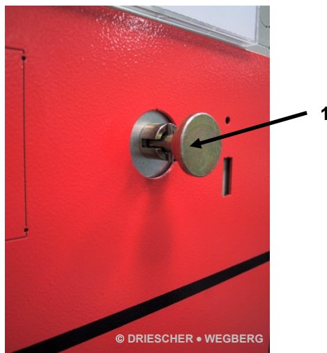
Áttétel kioldva/ gear unlocked
