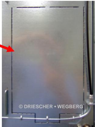
Um eine unsachgemäße Auslösung des Anti-Berst Systemes zu verhindern, ist die Sensorklappe mit dem Verbotsschild – „Berühren verboten“ gemäß DIN 4844-2 DGUV Vorschrift 9 versehen.
