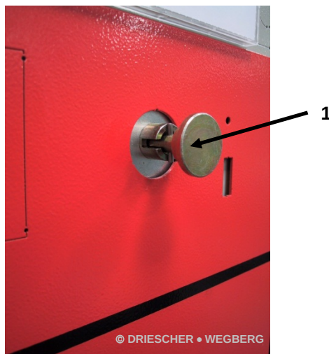
Getriebe entriegelt Engrenagem destravada
