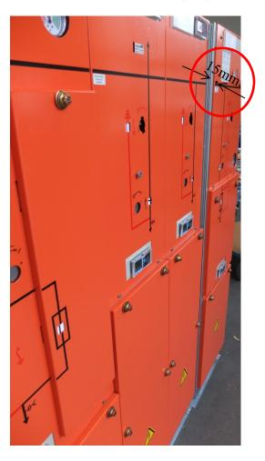
Beim Aufstellen darauf achten, dass die Anlagenteile gerade und auf einer ebenen Fläche aufgestellt werden. Die Anlagenteile müssen mit ihren Seitenwänden bündig zueinander stehen.
