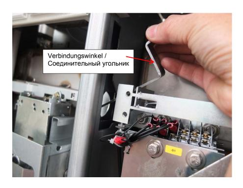
Anbindung des Verbindungswinkels an die ABS Auslösemechanik
