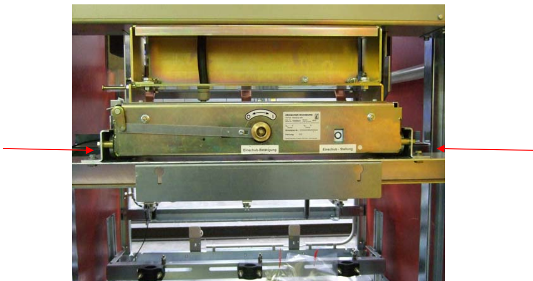
Bild 1 / Fig. 1 Ausfahrsperr/drawout interlock
