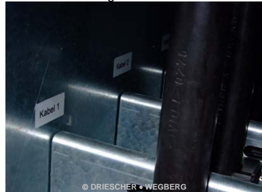
Anschlussreihenfolge/ order of connection
